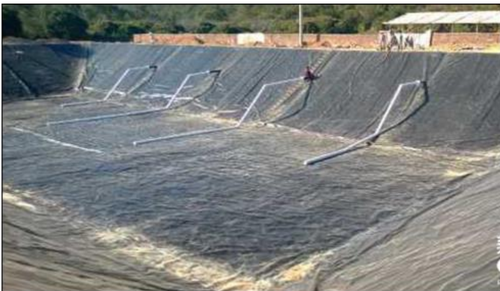
图3. 1-8黑膜沼气池内部示意图
